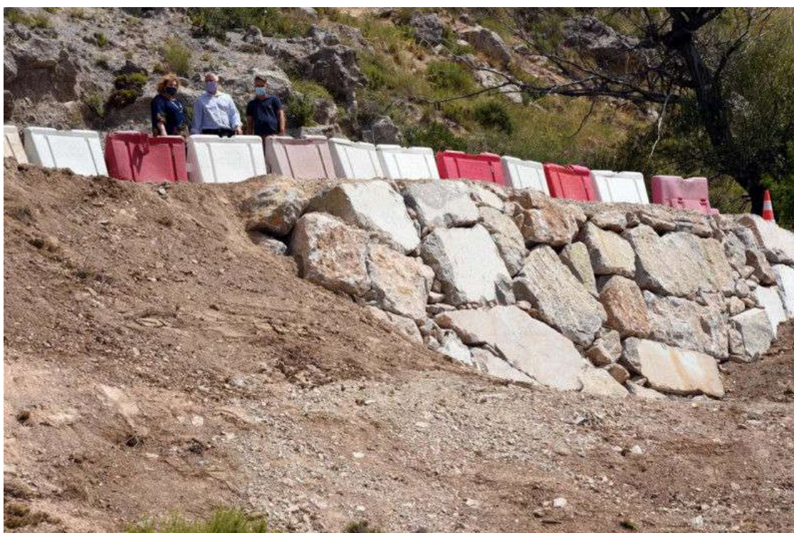
Imagen de archivo de Diputación realizando trabajos de reparación en la carretera de la Alfaguara (DIPUTACIÓN DE GRANADA)
