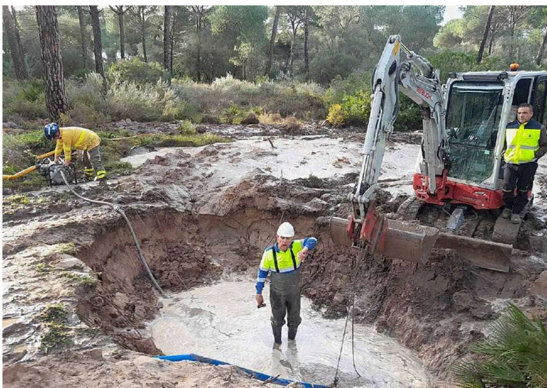
Trabajos de reparación de la tubería de abastecimiento de agua afectada por el temporal en Hinojos plan infoca
