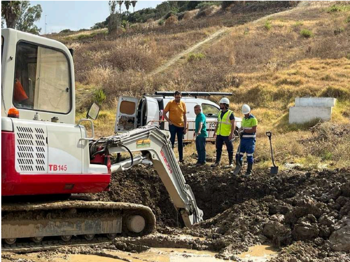
Reparación de una avería anterior por parte de los técnicos de Emalgesa.
