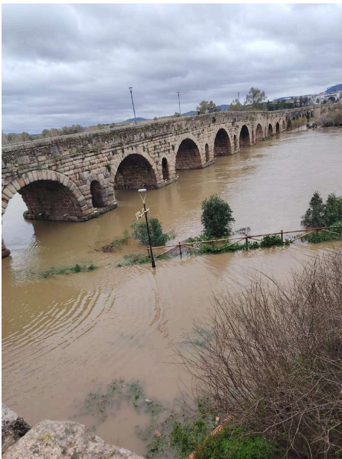
La crecida del río Guadiana a su paso por Mérida anega el parque de La Isla. / El Periódico Extremadura
