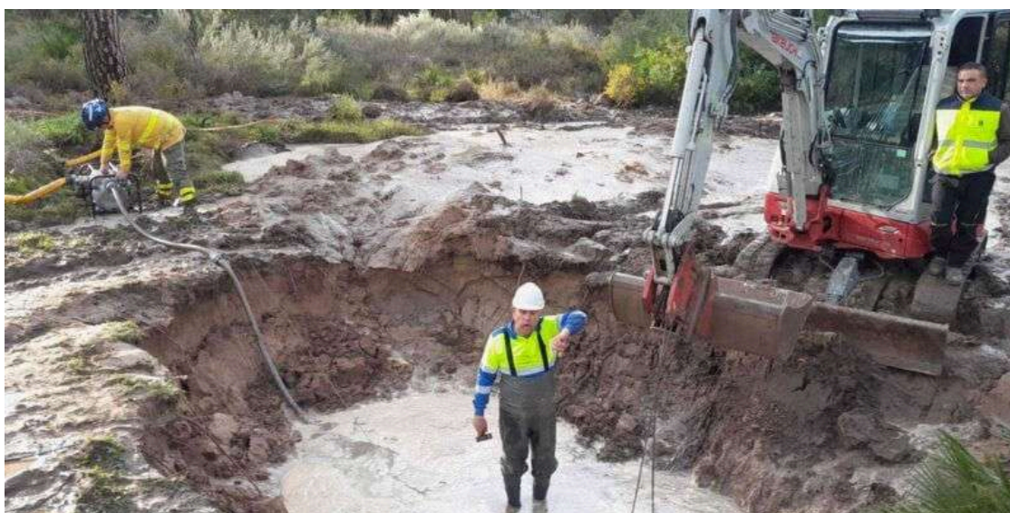
08/02/2026 Trabajos de reparación de la tubería de abastecimiento de agua afectada por el temporal en Hinojos (Huelva). POLITICA ANDALUCÍA ESPAÑA EUROPA HUELVA SOCIEDAD PLAN INFOCA
