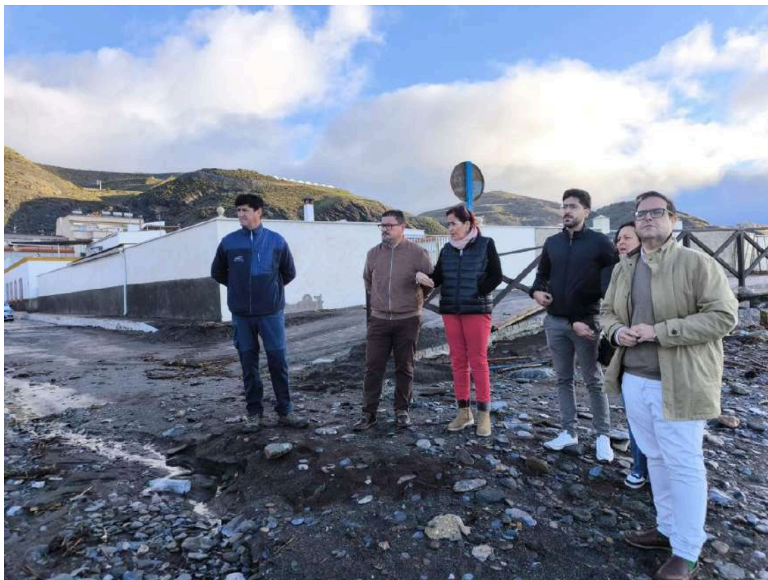
Visita a algunos de los daños provocados por las borrascas en la Costa Tropical (EL FARO)
